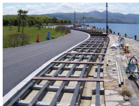
木芯入り擬木の根太。根太の上に擬木の板材を貼付施工
